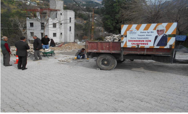
22-Akarca mahallesinde muhtelif yerlerde parke taşı döşeme çalışmaları yapılmıştır.
