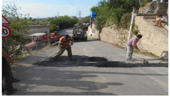
25-Sariseki mahallesinde Müdürlüğümüz ekipleri tarafından bozulan ve tahrip olan asfaltın tahrip olan kısmın bakım onarımı yapılarak daha düzgün hale getirilmiştir.
