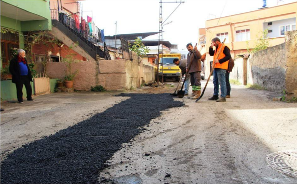
39-İlçemiz Dumlupınar mahallesinde bozulan ve tahrip olan asfaltın bakım onarımı Fen İşleri Müdürlüğümüze bağlı ekipler tarafından asfalt yama yapılmıştır.
