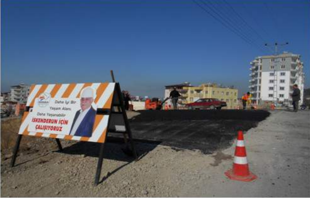
1-İlçemiz Denizciler mahallesi Mehmet Akif caddesi üzerinde Fen İşleri Müdürlüğü ekipleri tarafından asfalt kaplama yapılmıştır.
