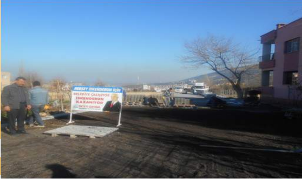
3- Bekbele mahallesi Mehmet Akif caddesi üzerinde parke döşemesi yapılmıştır.
