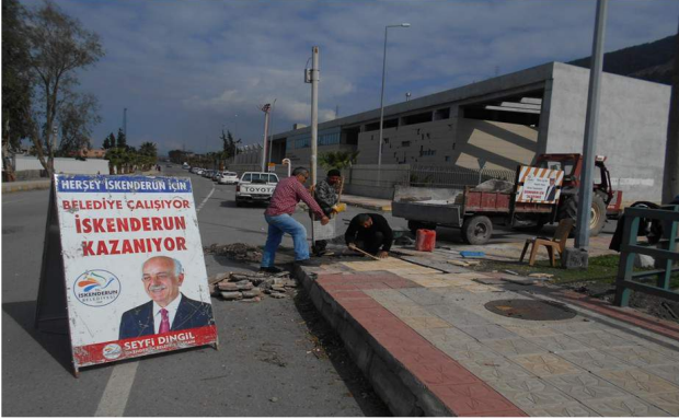
24- Sarseki mahallesinde Tayfun Sökmen caddesi üzerinde bulunan Meslek lisesi okulu kaldırımında hava şartların dandolayı bozulan deforme olan kaldırımında engelli rampası yapılmıştır
