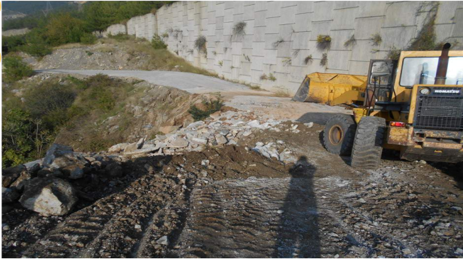
15- Sariseki mahallesi çevre yolu otoban menfez çıkışında selden dolayı oluşan hafriyat dolum ve betonlama çalışması yapılmış olup, yol açılarak kullanılabilir hale getirilmiştir.
