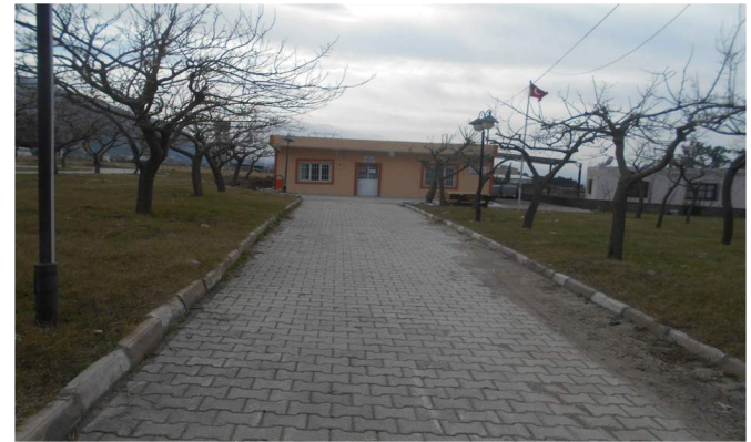
10- Çınarlık mahallesi muhtarlık binası tamirat tadilatı yapılmıştır.
