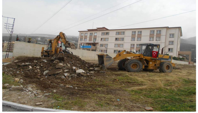
23- Denizciler mahallesinde bulunan Şirinyurt İlkokulunun çevresinde düzenleme ve tesviye çalışması yapılmıştır.
