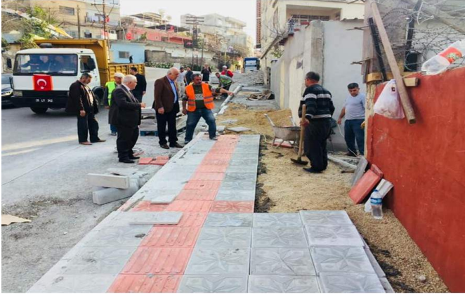
49-İlçemiz Barıştepe mahallesinde müdürlüğümüz ekipleri tarafından kaldırım yenileme çalışmaları yapılmıştır.
