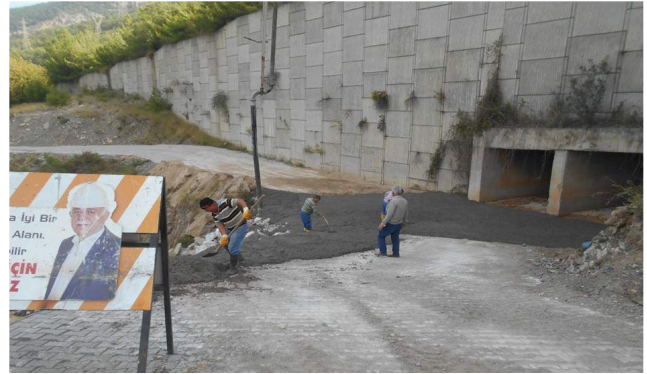
15- Sariseki mahallesi çevre yolu otoban menfez çıkışında selden dolayı oluşan hafriyat dolum ve betonlama çalışması yapılmış olup, yol açılarak kullanılabilir hale getirilmiştir.
