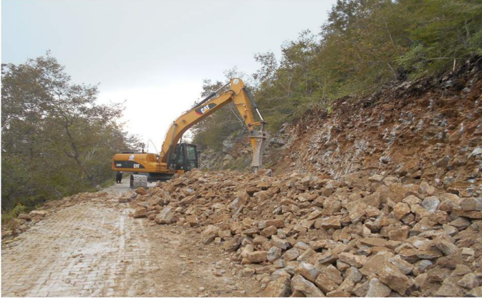
7- Bitişik mahallesi İspatan yaylası yolu genişletme çalışması yapılmıştır.
