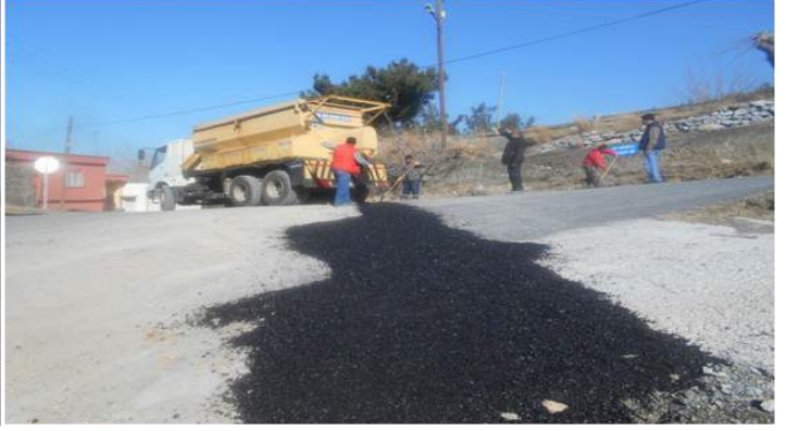
2- Fen İşleri Müdürlüğü ekipleri tarafından Kavaklıoluk mahallesinde asfalt yama çalışması yapılmıştır.
