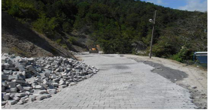
4- İlçemiz Sarıseki mahallesi Bedrik yaylası yolu parke kaplama çalışması yapılmıştır.
