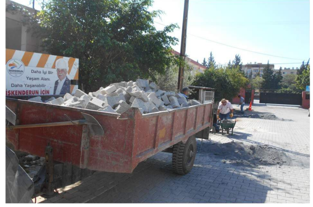
8- Denizciler mahallesi 115. Sokakta bulunan İmam Hatip Orta Okulu karşısında hava şartlarından kaynaklı kaldırım tahribatının giderilmesi için parke tamirata yapılmıştır.
